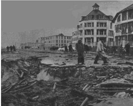
De boulevards van onze badplaatsen kregen het zwaar te verduren. De hoog overslaande golven beukten grote gaten in het wegdek en brachten zware schade toe aan de bestrating. De boulevard van Noordwijk aan Zee moest het tegen het watergeweld gedeeltelijk afleggen.
